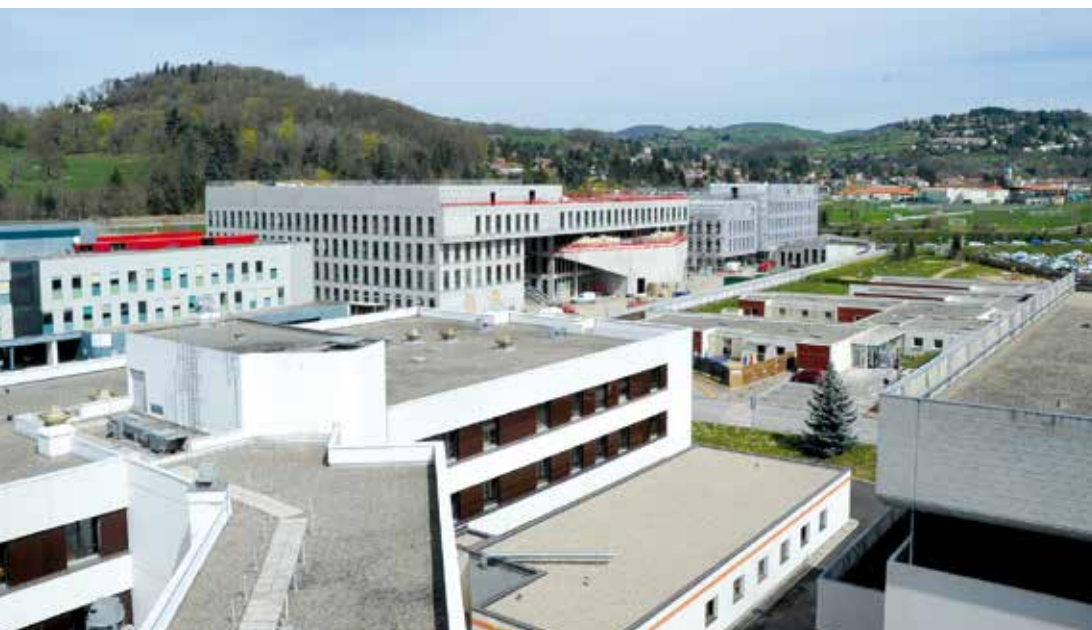
Chantier du Pôle Santé avec notamment la Faculté de Médecine - Hôpital Nord
